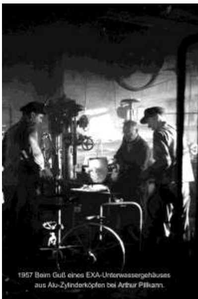
1957 Guß eines Aluminiumgehäuses für die Unterwasserkamera EXA unter primitiven Bedingungen aus Zylinderköpfen bei Arthur Pillkann
