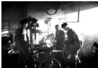
1957 Guß eines Aluminiumgehäuses für die Unterwasserkamera EXA unter primitiven Bedingungen aus Zylinderköpfen bei Arthur Pillkann
