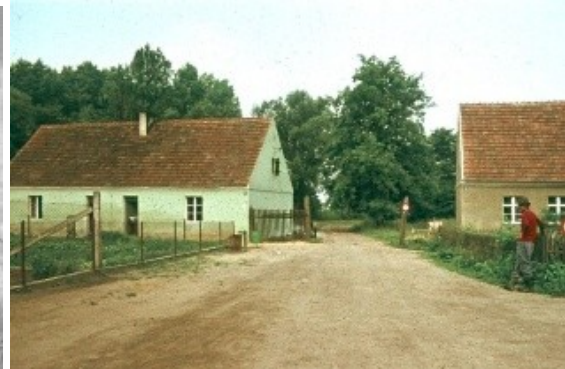
Die alten Schnitterkasernen des ehemaligen Gutshofes die uns Zuflucht vor dem Gewitter boten.
