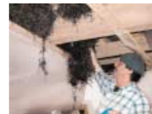
Seegrass kann in Zwischendecken gestopft zur Wärmedämmung genutzt werden.
